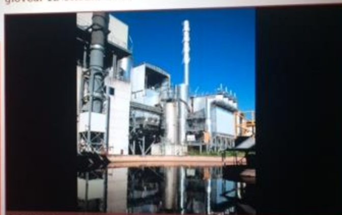
FAENZA Centrale termica
